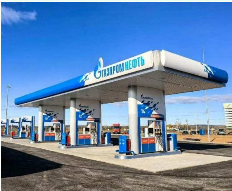
ООО «ИНВЕСТ СТРОЙ» 273 млн руб., ввод 2024 г.
